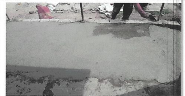
Foto 6: Reparación de torta de cemento
