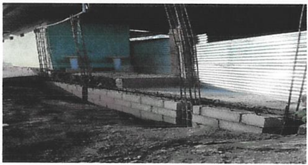
Foto 3: Sustitución de muro frontal
