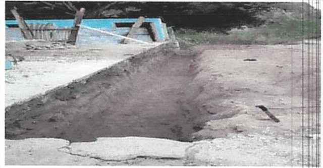
Foto 2: Cimentación profunda para muro frontal nuevo
