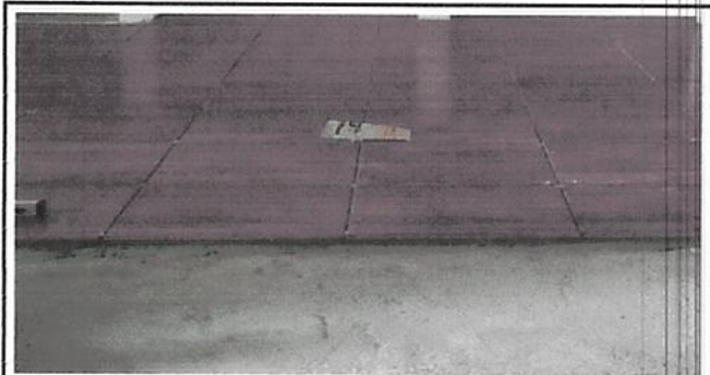
Foto 4: Sustitución de torta de cemento por piso cerámico alto trafico
