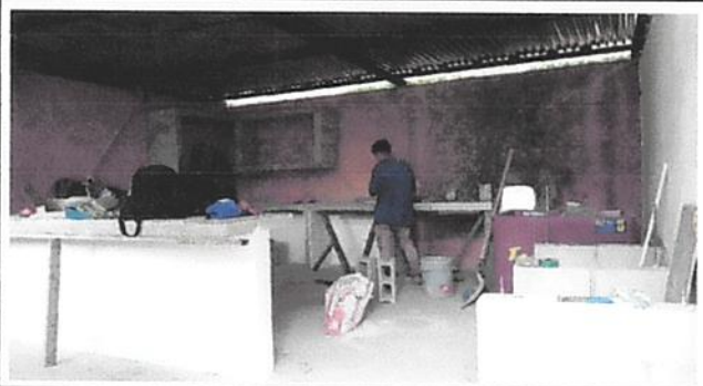
Foto 1: Gabinetes de seis módulos, sustitución de pila de concreto por pila plástica de un lavadero, sustitución de estufa rural (completa)
