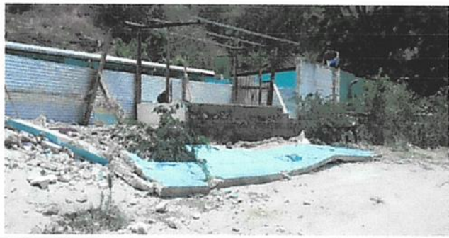
Foto 1: Demolición del muro frontal antiguo
