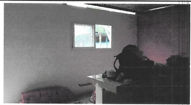
Foto 2: Mesón de 3.00x0.60x0.90 mts con azulejo aspen blanco de 20x30 y cernido de pared con monocapa
