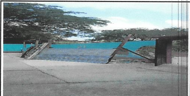
Foto 6: Sustitución de muro frontal
